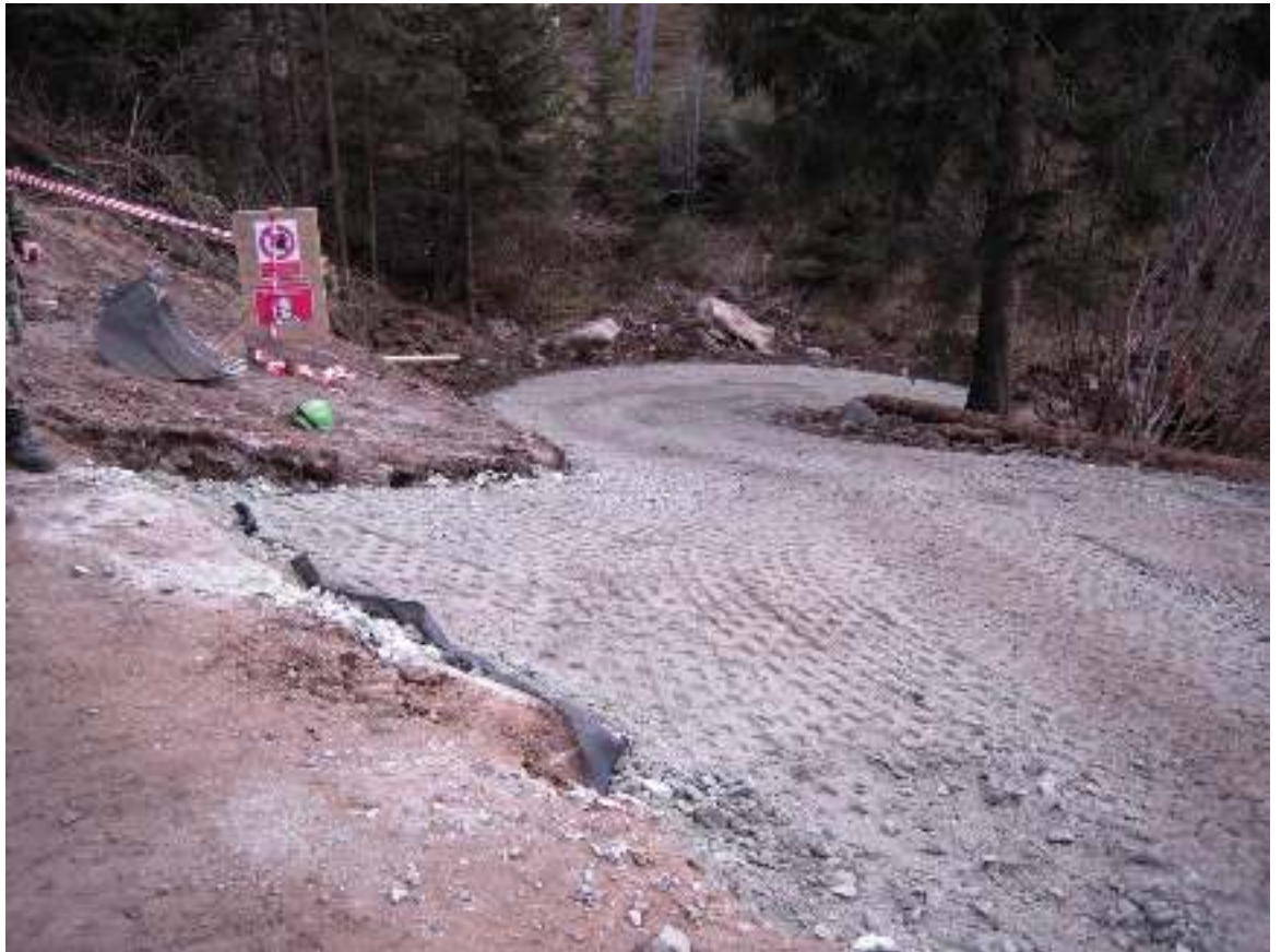
Abbildung 7 Der Einlenker mit Kurve am Süden nach Tragschichteinbau auf Geotextil
