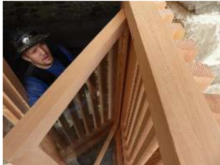
Bild rechts: Fensterflügeltest alles massgenau!
