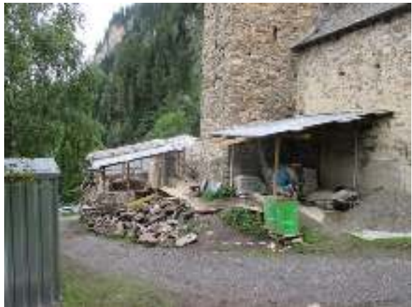
Bild rechts: Baustellenorganisation, Mischplatz
