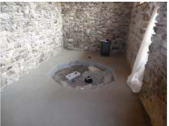
Bild rechts: fertiger Mörtelboden mit Gasheizung
