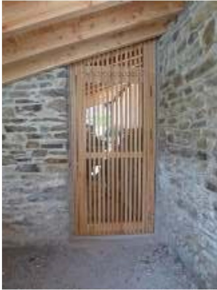
Bild links: fertige Türe montiert
