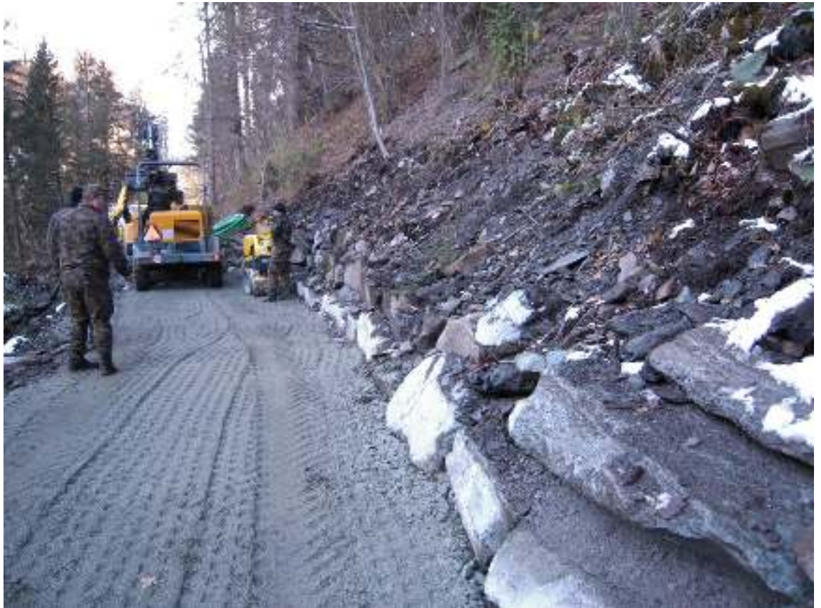
Abbildung 13 Die Tragschicht wird eingebaut
