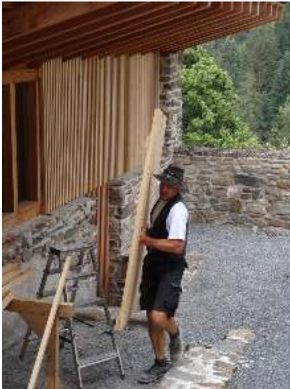
Montage Fassadenleistenrahmen
