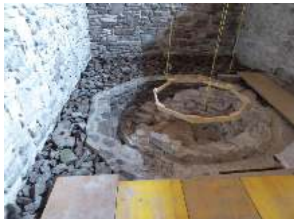
Bild rechts: beendete Aufmauerung und Auffüllung
