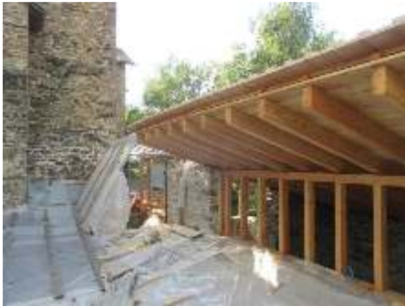
Bild links: Die Montage ist abgeschlossen
