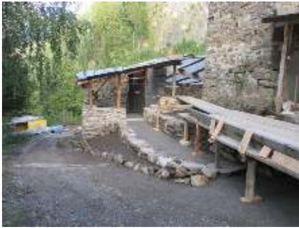
Bild links: Der Westzugang noch mit Rampe zu Raum 2
