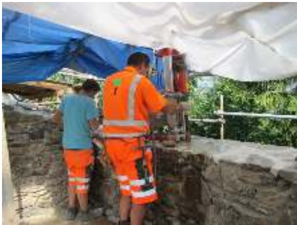
Bild links: Mit der Kernbohrmaschine werden die 60 cm und 30 mm Ø Löcher gebohrt
