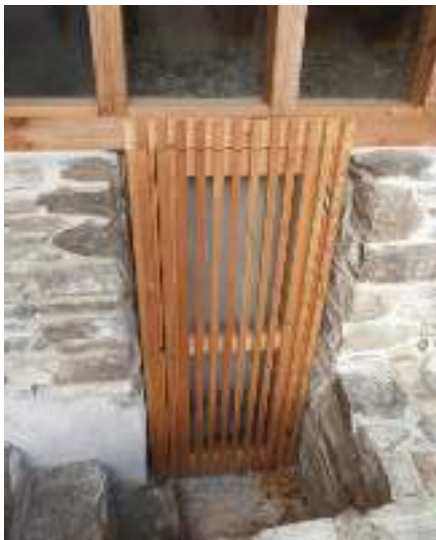
Bild links: Türe fertig montiert
