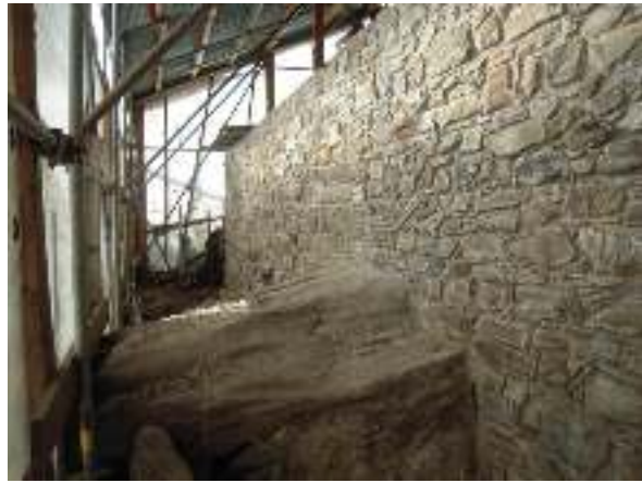
Mauer M 26 Richtung Südecke M 26 / M 533
