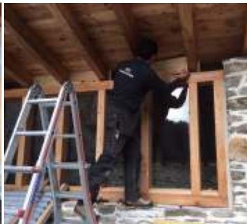
Bild rechts: Schliessung Oberlichter mit Sparenbrettern
