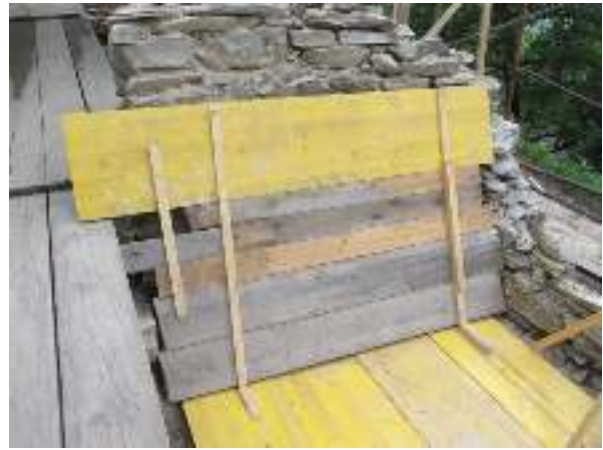
Bild rechts: Der originale Wandmörtel wird geschützt
