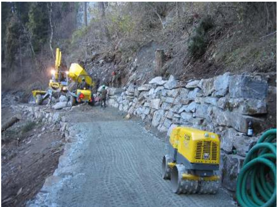
Abbildung 6 Blocksteinmauer als Stützbauwerk
