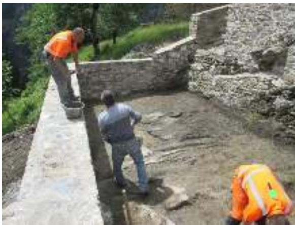
Bild links: Vorbereitung Auffüllung der Löcher
