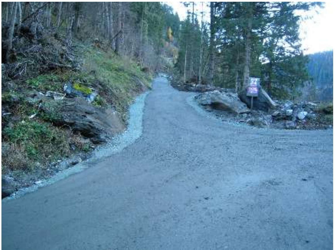
Abbildung 16 eingewalzte Verschleisssschicht am Nordende
