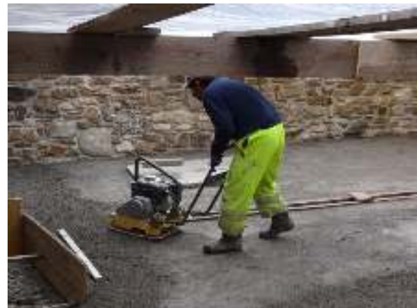
Bild rechts: Altar- und Chorschrakenmarkierung. Verdichten der Verschleisssschicht
