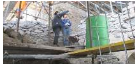
Die Mauern wachsen und die Details werden gepflegt. Bereits wird der Abbruch des Schutzdaches geplant, die erste Arbeit im 2015
