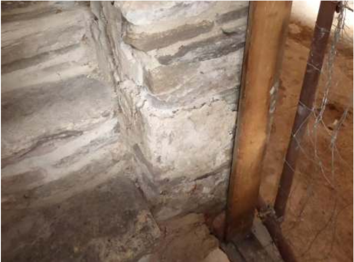
An der westlichen Mauer der Türöffnung Süd ist der zu überdeckende Wandverputz erkennbar.
