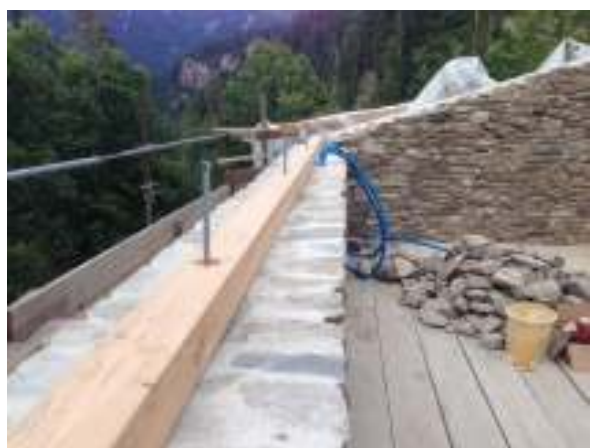
Bild rechts: Die Gewindestangen werden eingegeossen An ihnen wird das Dach befestigt
