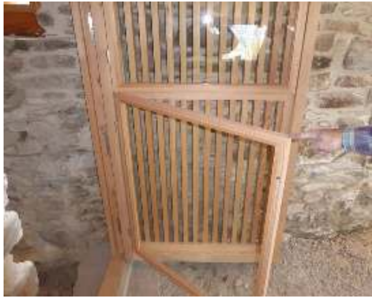
Bild rechts: Fensterflügelöffnung für Reinigung
