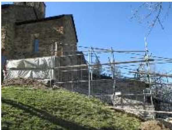
Bild links: Die Demontage ist weit fortgeschritten
