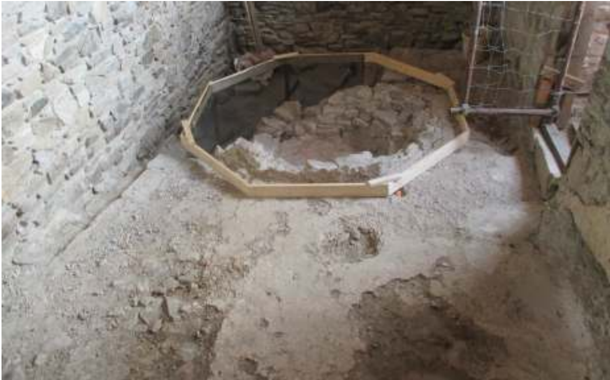
Der originale Mörtelboden im Baptisteriumsraum (Bau 1) mit dem Taufbecken und einem Holzmodell des Rahmens um das Taufbecken. Im Hintergrund die NO Ecke, die aufgefüllt wird. Rechts die Türe Süd.
