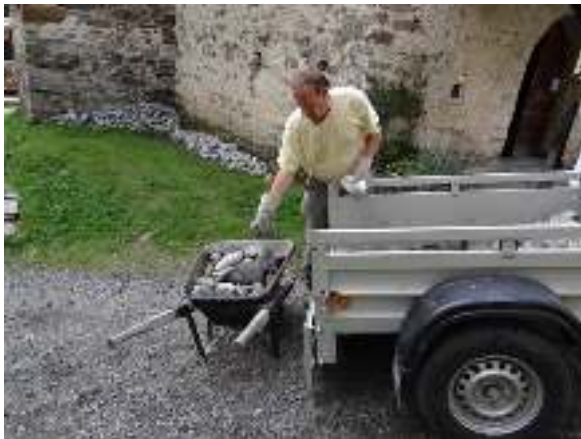
Bild links: Auslese und Antransport Rollierungssteine
