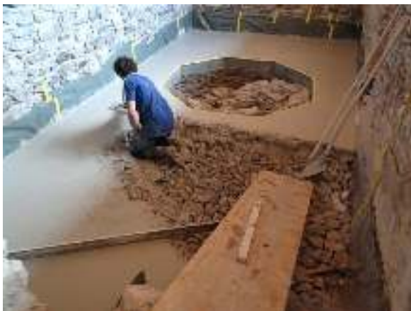
Bild links: Zwischenstand Mörtleinbau
