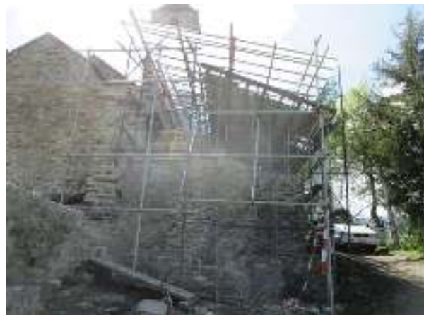
Bild rechts: Schutzdach über Bau 1 muss höher werden
