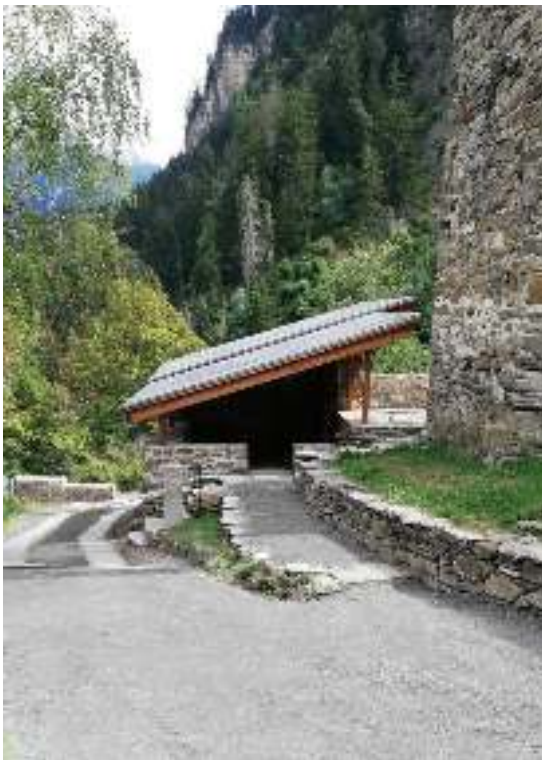
Terre und Kassastock vor Vorraum
