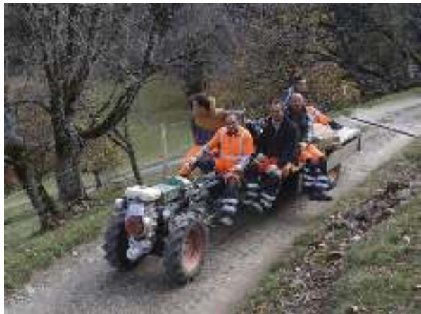
Bild rechts: Die Maurer und Maschinisten der Firma Othmar Caviezel GmbH leisteten 2015 ganze Arbeit
