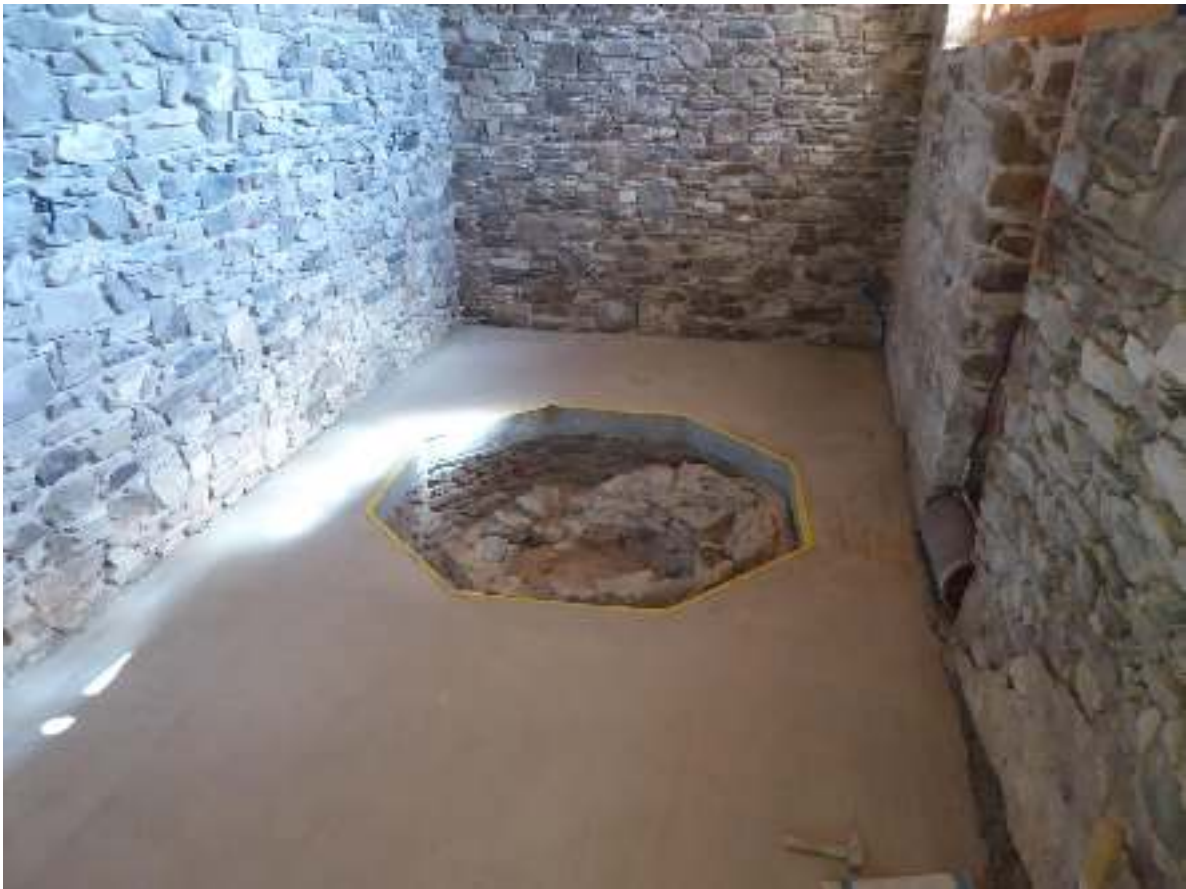
Der eingebaute neue Mörtelboden Stand 22.9.2017
