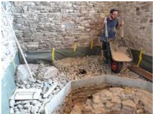
Bild rechts: Mörtleinbringung auf die Rollierung
