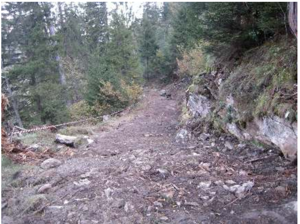
Abbildung 4 Das Trasse am Südende
