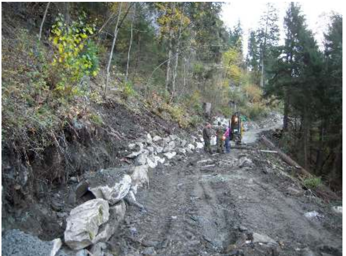
Abbildung 12 Hoher Besuch auf der Baustelle. Der Blockwurf geht in die Endphase
