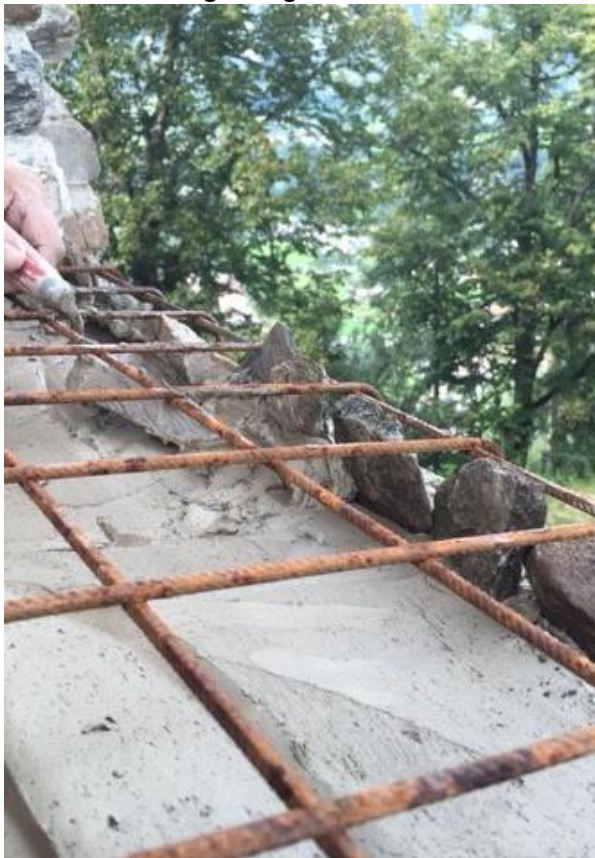
Mauerkronenbegrünung: Vorarbeiten Lehmauftrag und Haltegitter
