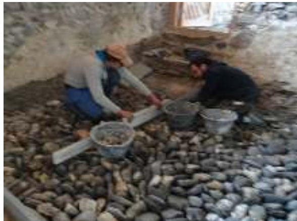
Bild rechts: Einlegung Rollierung
