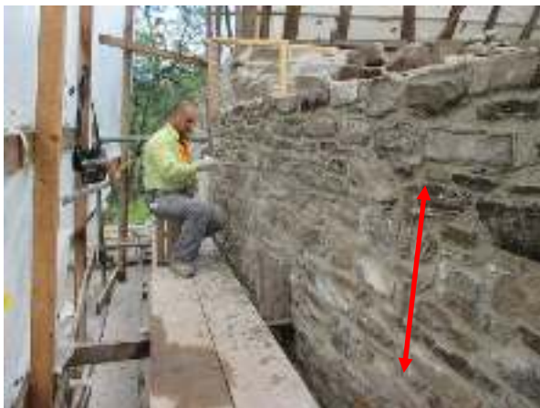
Bild links: Fugenbearbeitung an der Ostmauer über der Apsis, deren Begrenzung markiert ist
