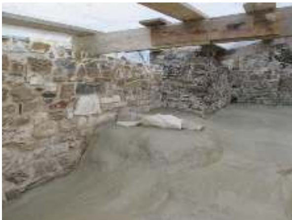
Bild links: Die Lehmabdeckung ist fertig
