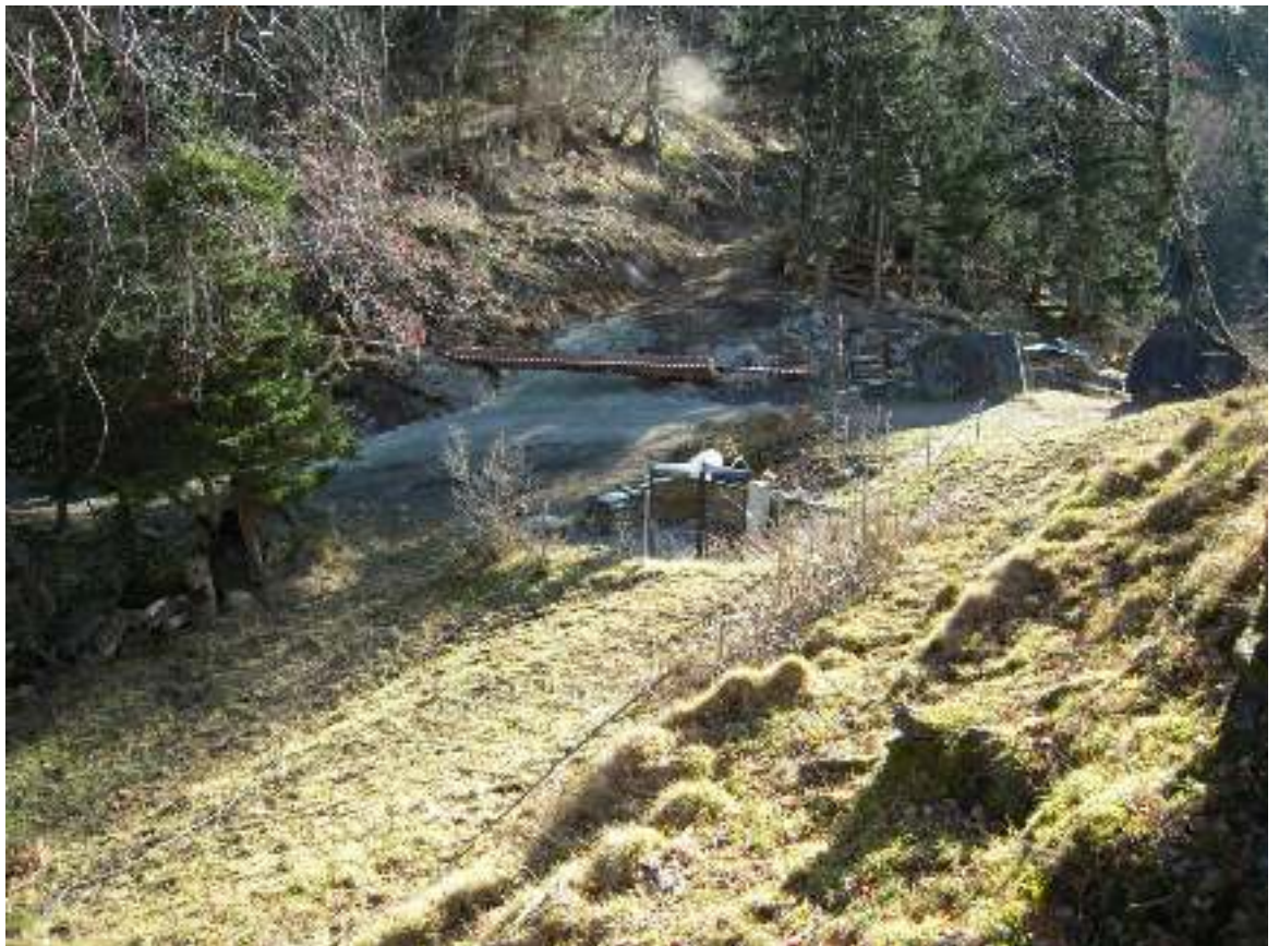
Abbildung 8 Die Absperrung für die Winterpause am 30.11.2011
