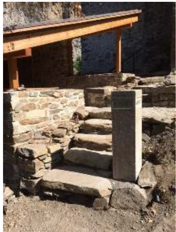
Die Terre ist von der Vormauerung abgesetzt
