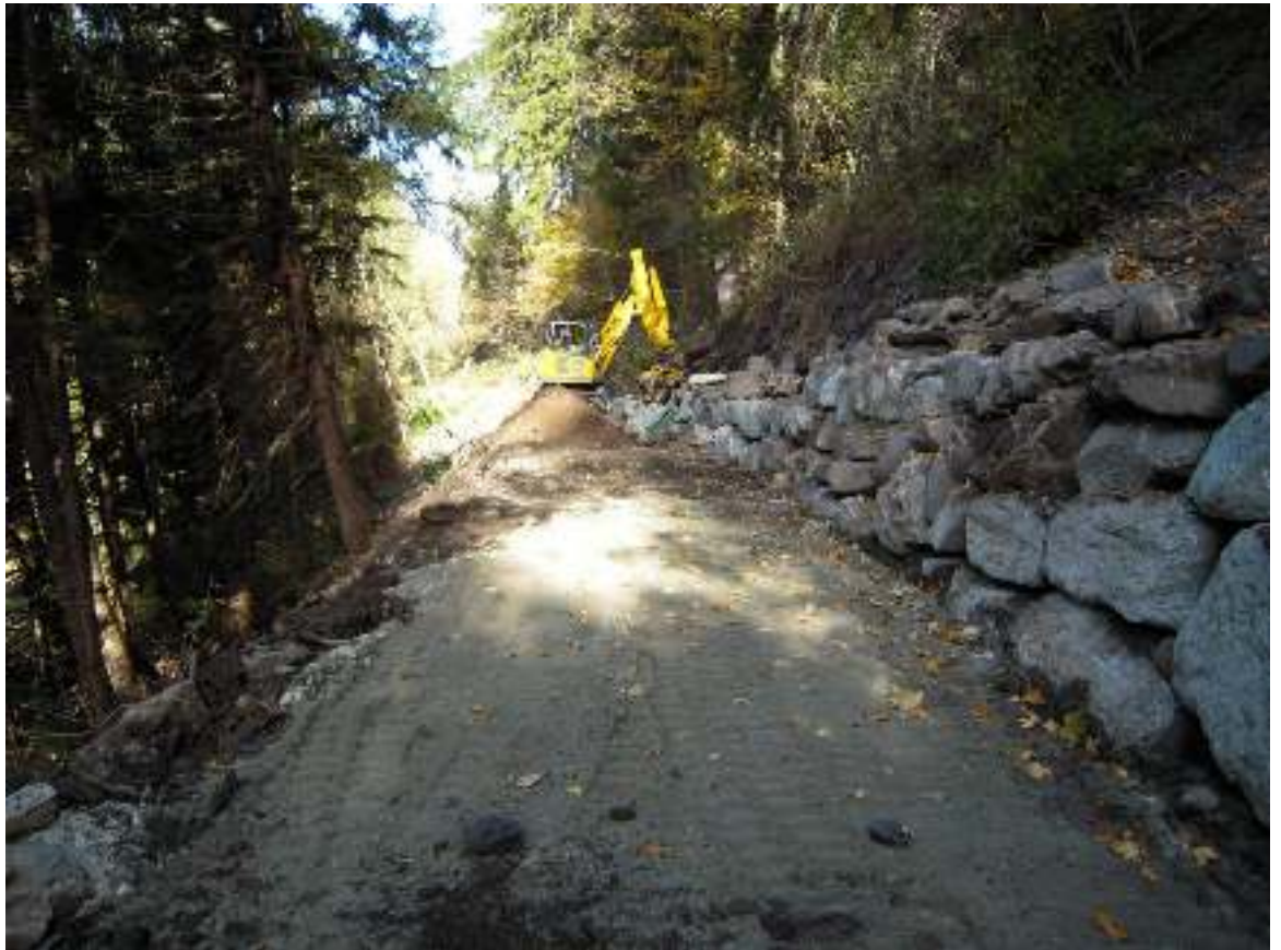
Abbildung 11 Der bergseitige Blockwurf wird fortgesetzt
