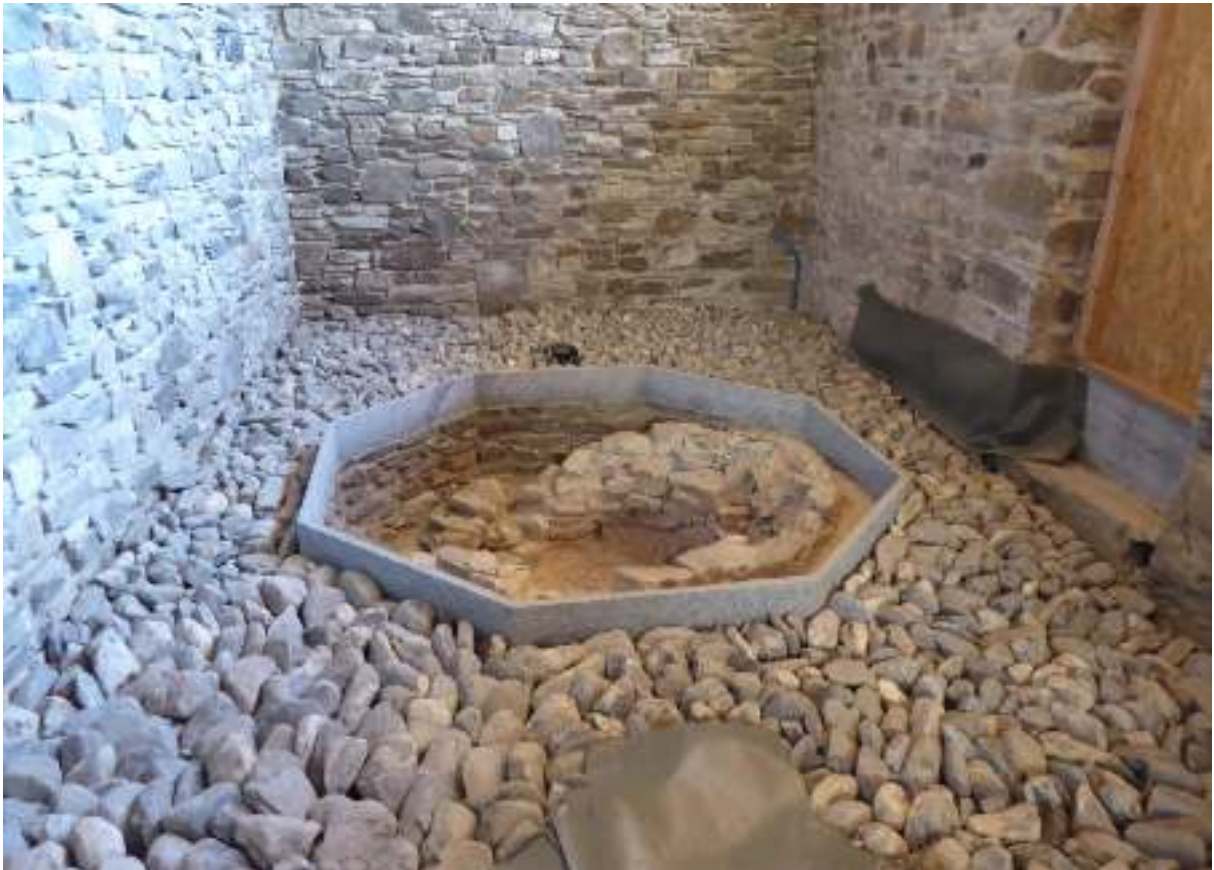
Stellsteine in regelmässigem Achteck und die fertige Rollierung
