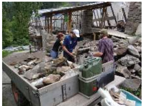
Bild rechts: Die Bereitstellung von Mauersteinen ist Sammlearbeit und geht nur von Hand
