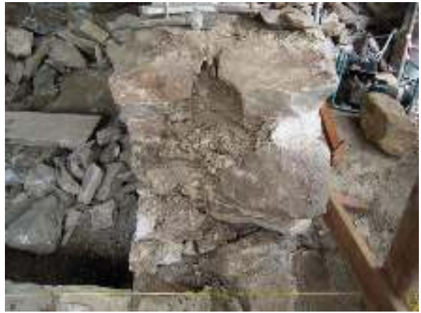
M8, Originalmörtel mit ausgewaschenem Bindemittel
