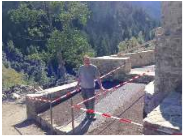
Bild rechts: Der Zugang zu Raum 7, frisch angesät durch den Bauherrn
