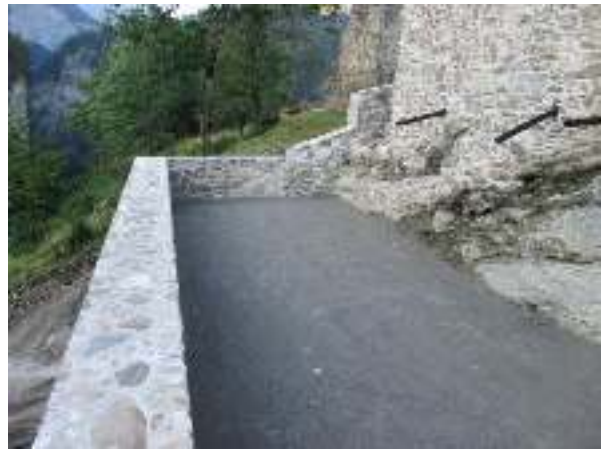
Bild rechts: Die Verschleisssschicht ist eingewalzt
