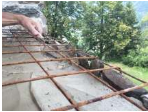
Bild rechts: Das Haltegitter mit den Randsteinen
