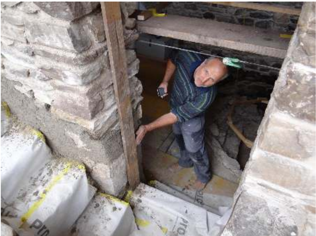
Der Restaurator am Anbringen der Überdeckung
