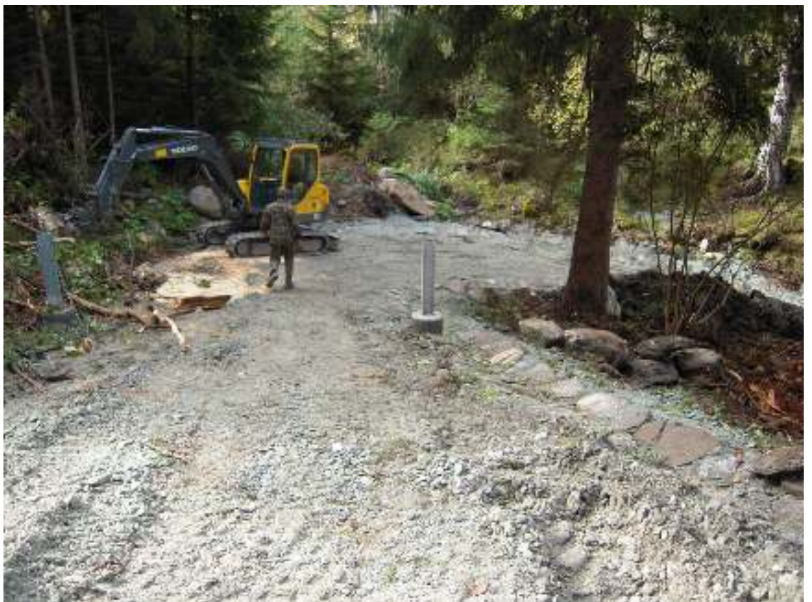
Abbildung 10 Aufräumen nach Föhnsturm am 11. Oktober 2012
