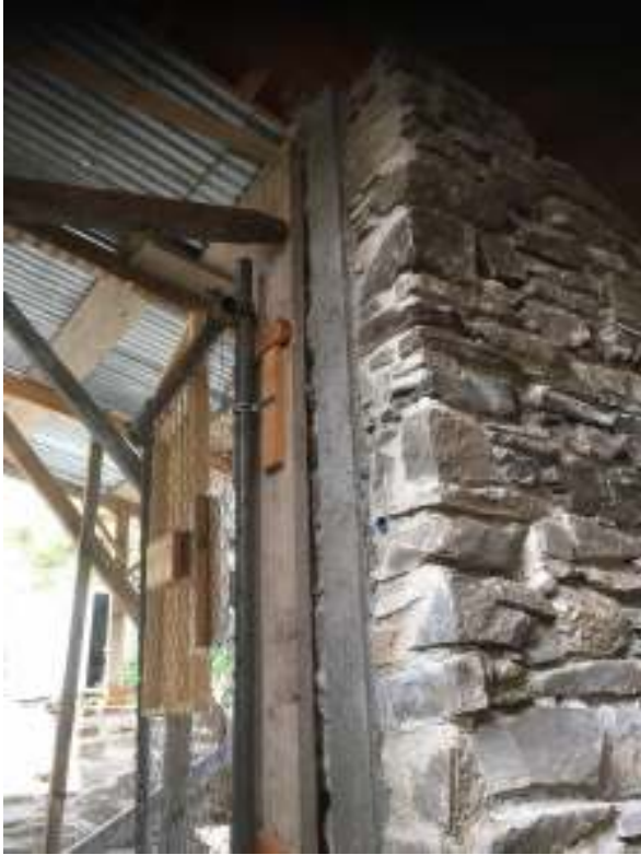
Mörtelband als Anschlag für den Türrahmen
