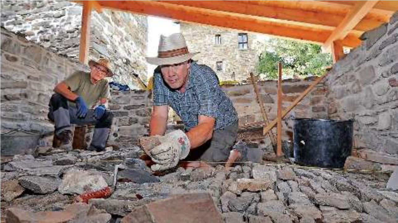
Schweisstreibend auch unter dem Schutzdach: Projektleiter Rudolf Küntzel (links) und «Burgherr» Ruedi Jecklin erstellen vor dem Baptisterium von Hohen Rätien einen Natursteinboden.
