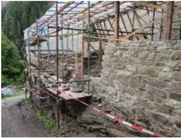
Bild links: Das Gerüst ist bereit
