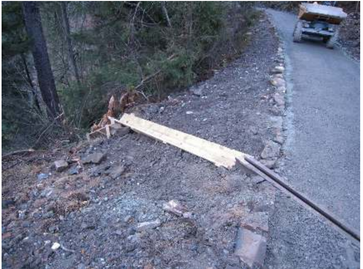
Abbildung 17 eingelassene V-Kännel und Strassenberandung
