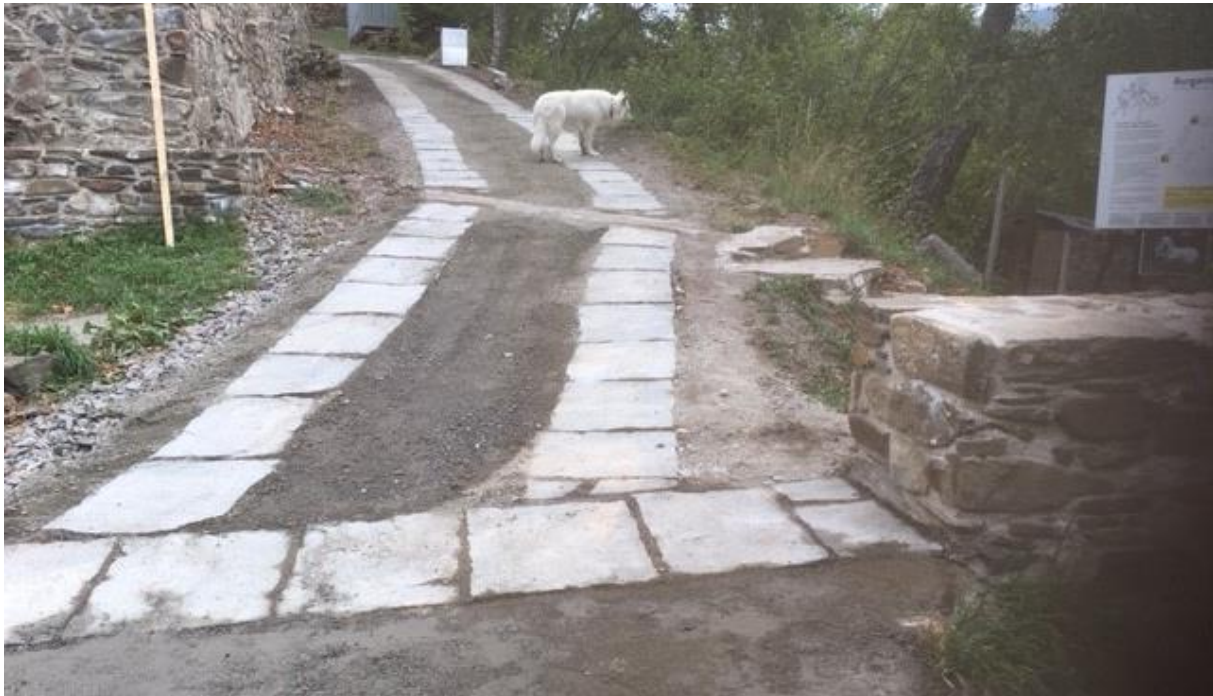
Die Auffahrt mit Steinplattenbesatz in den Fahrspuren
