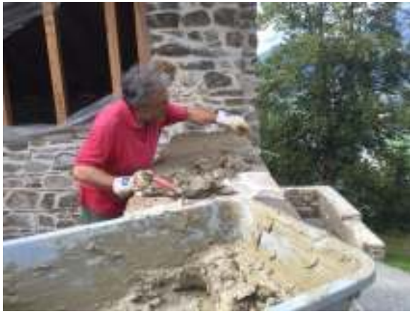
Bild links: Zuerst wird eine Lehmschicht aufgetragen
