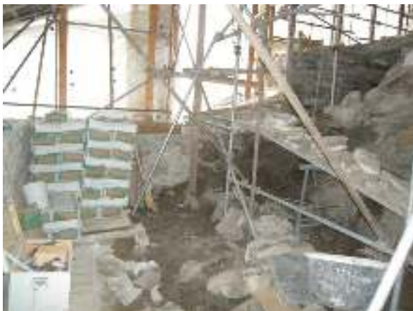
Mauersprung (Fuge) bei M 330 zu M 573
