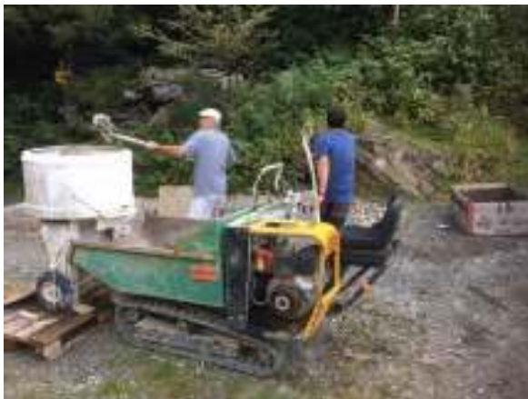
Bild links: Mörtelaufbereitung
