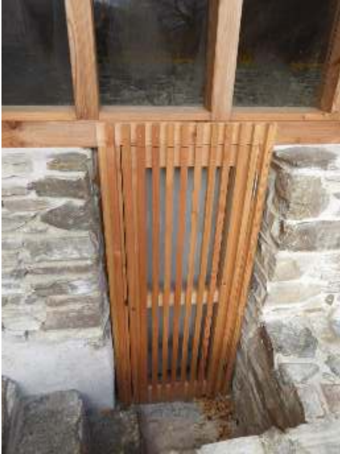
Türe Süd eingebaut. Die Latten sind zum Taufbecken leicht abgewinkelt.
