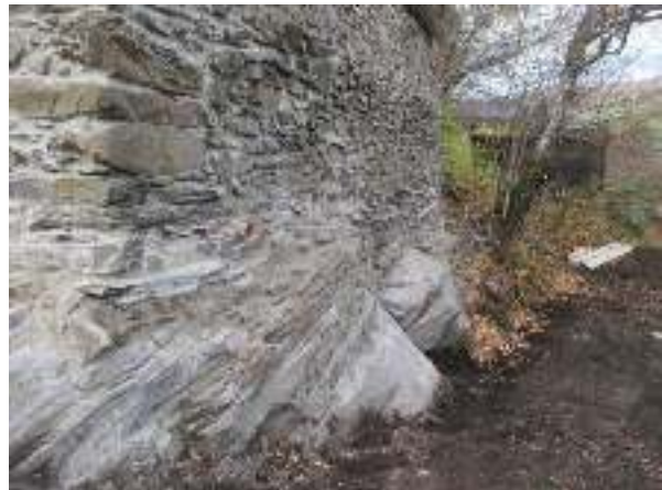
Bild rechts: Unterseite der Umfassungsmauer, die auf Fels fundiert.
