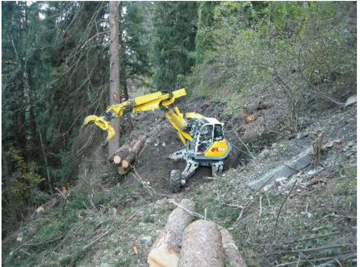
Abbildung 5 Abtrag und Deponierung der Baumstämme
