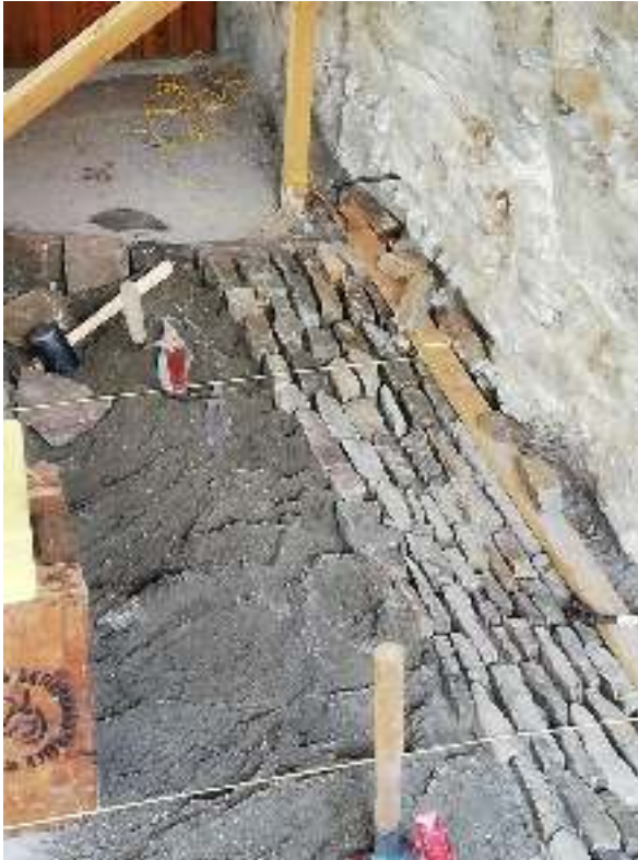
Der Pflasterungsbeginn im Vorraum
