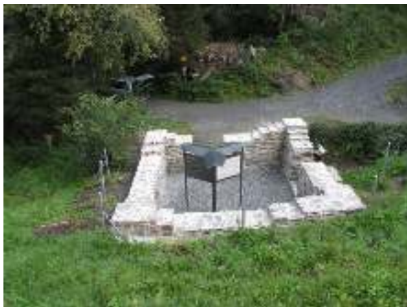
Info-Stand und erste Kontaktstelle zu Hohenrätien mit saniertem Mauergeviert (nach Vandalenakt)
