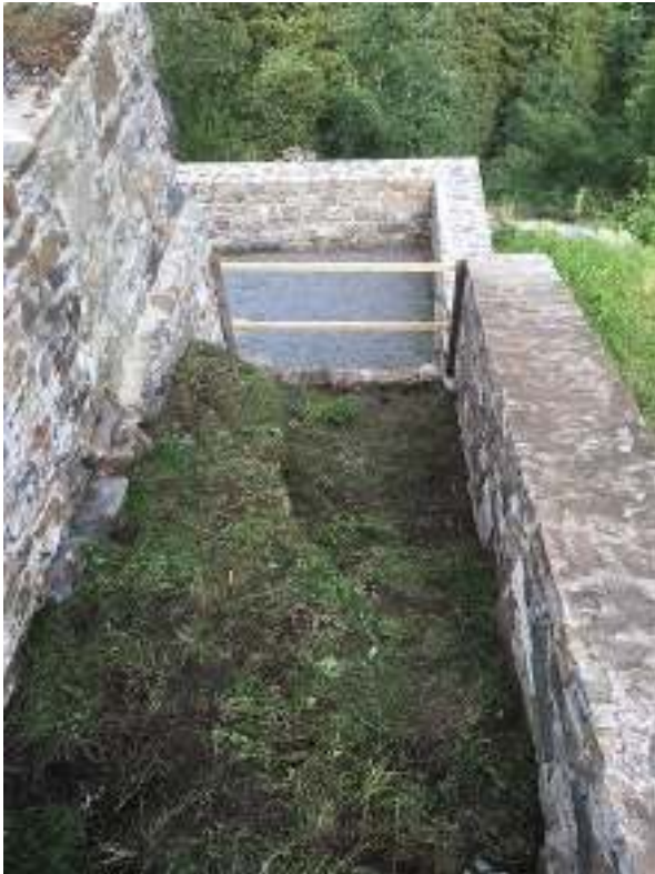
Abdeckung Felsoberfläche mit Rasenziegel
