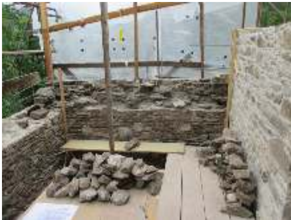
Bild links: Über dem geschützten Taufbecken Bereit für die Aufmauerung
