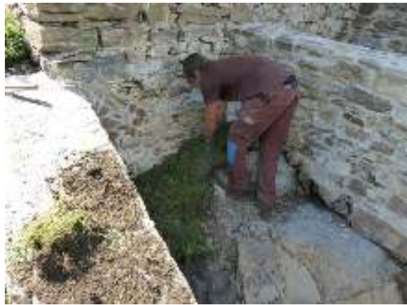
Bild rechts: Verlegung von Rasenziegel durch ZIVIS
