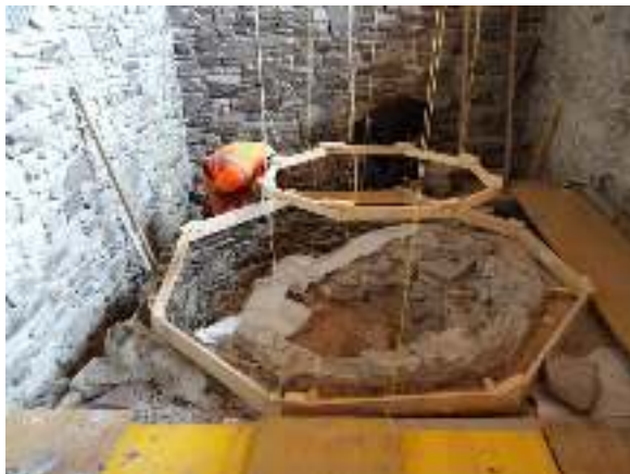
Bild links: Aufmauerung in Arbeit
