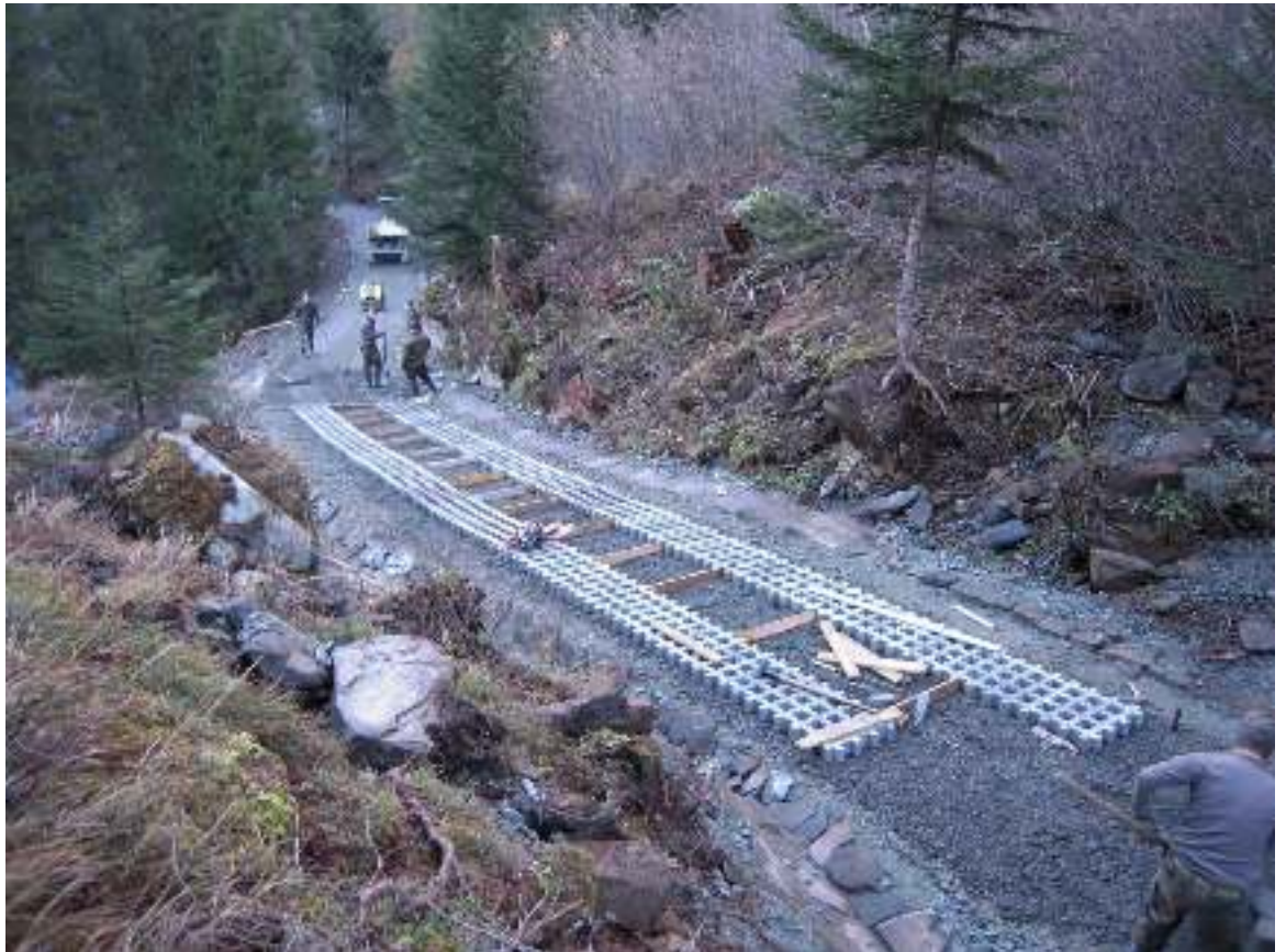
Abbildung 15 Einbau der Rasengittersteine
