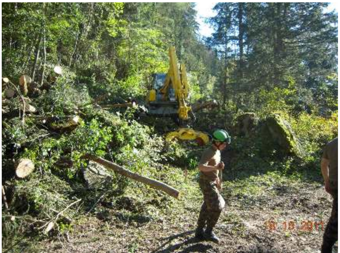
Abbildung 2 Beginn Trassefreilegung (Nordende)
