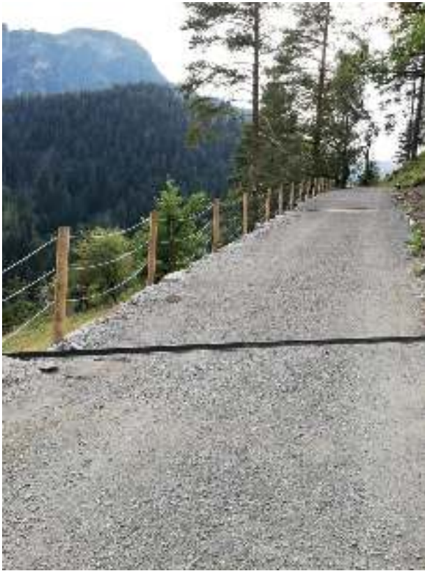
Querrinnen und Verschleisssschicht
