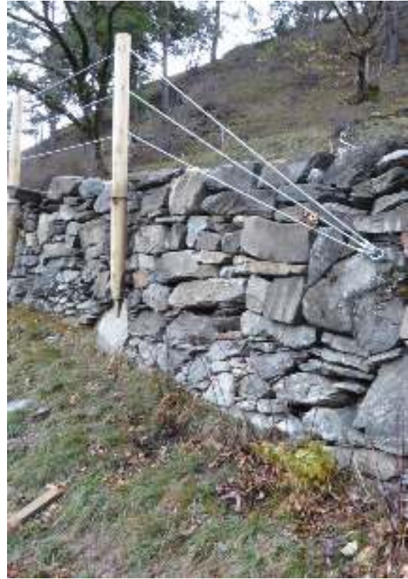
Geländerkonstruktion mit Endverankerung
